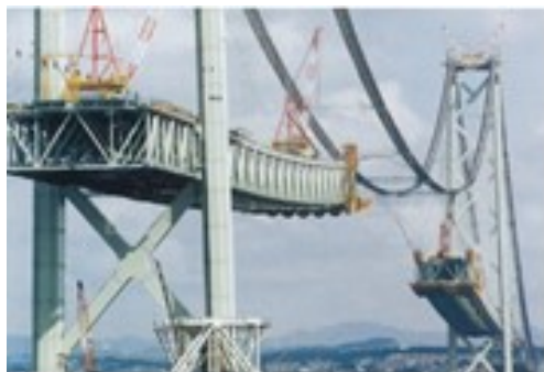
図9 面材張出し架設
