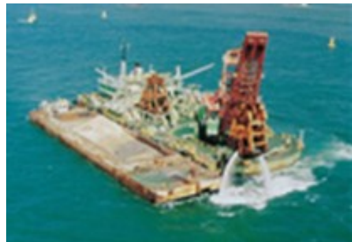
図2 大型グラブ船による掘削
