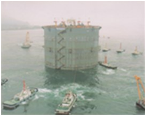
図3 係留作業中のケーソン
