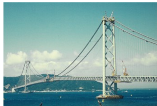
図10 桁閉合完了
