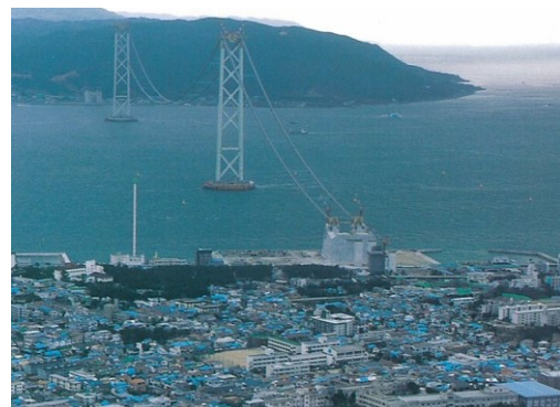
図5 震災直後の明石大橋
