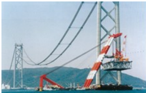
図8 桁の大ブロック架設
