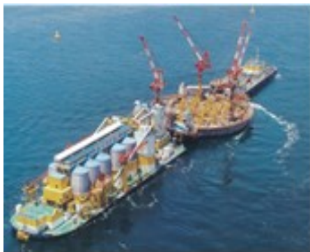
図4 水中コンクリートの施工
